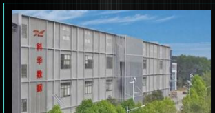
广州科云数据中心
