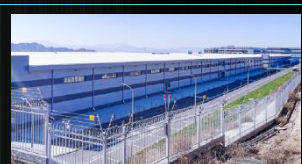
张家口腾致数据中心
