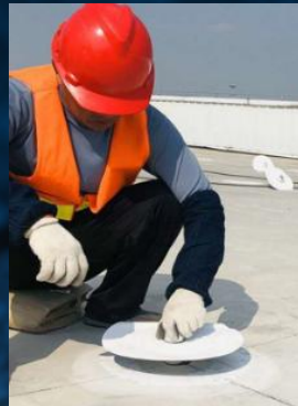
金属支座安装
