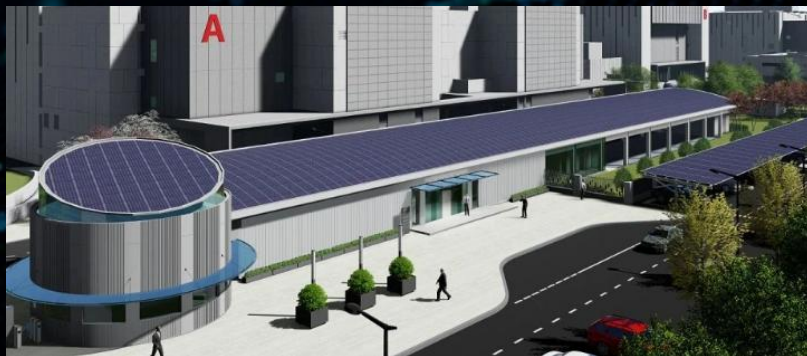
万国数据中心
