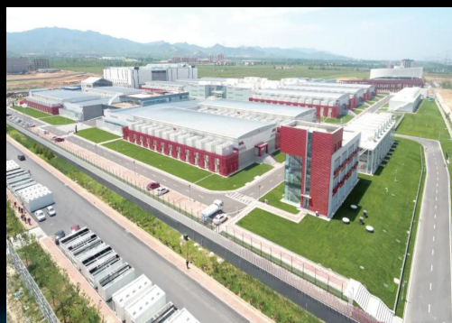
秦淮数据中心
