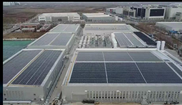
奥飞数据廊坊数据中心
